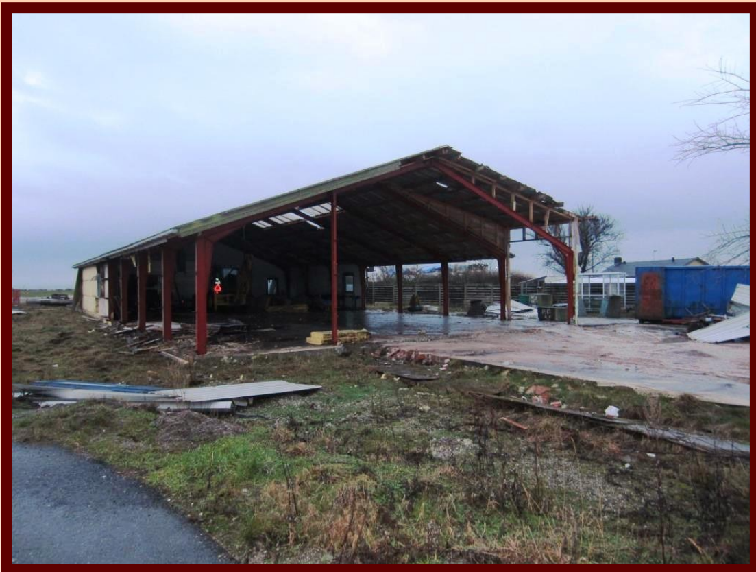
Færgemanns Maskinfabrik nedrives
