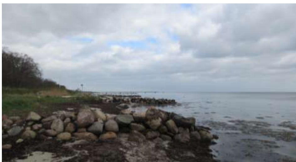
Figur 3-8 Høfder anlagt af Høfdeholderne fra 2004 til 2012. De sidste tre høfder blev afkortet for at reducere læsideerosionen mod syd. Billeder taget 21-04-2016 (foto: NIRAS).
