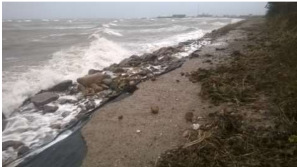
Figur 3-10 Stormhændelse ved skråningsbeskyttelse d. 22. november 2015. (Foto: Dorte Wissendorff).
