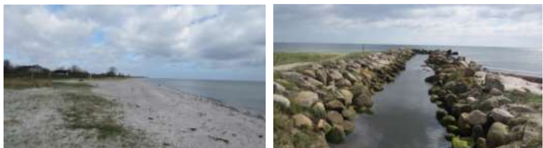
Figur 3-4 Udløbet af Spøttrup Bæk. Venstre: Tilsanding nord for bygværket (Spøttrup Strand). Højre: Dobbeltthøfden, der sikrer mod tilsanding af udløbet. Billeder taget 21-04-2016 (foto: NIRAS).
